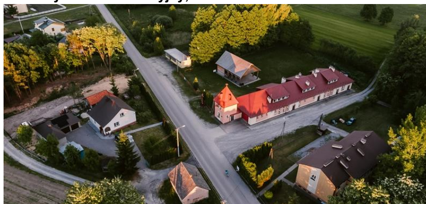
Zdjęcie 3. Budynek wielofunkcyjny, Remiza OSP w Przedborzu - widok z drona
